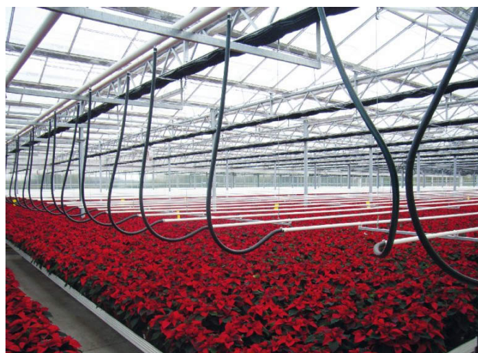
Die Hebe-Senk-Heizung sorgt für trockene Bestände
