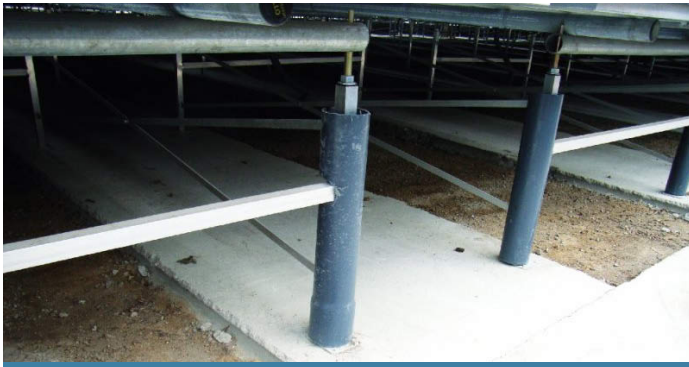
Die Zwischenwege wurden in Eigenleistung betoniert
