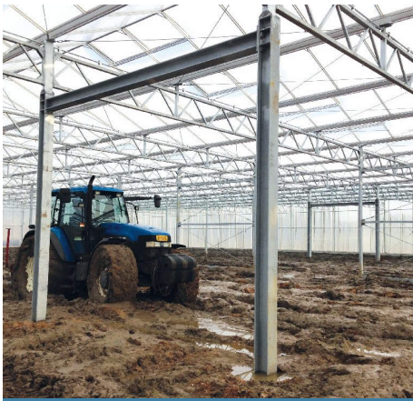
Tiefer Matsch stoppte die Arbeiten
