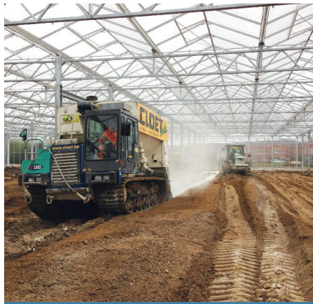
Einbringung von ungelöscht Kalk
