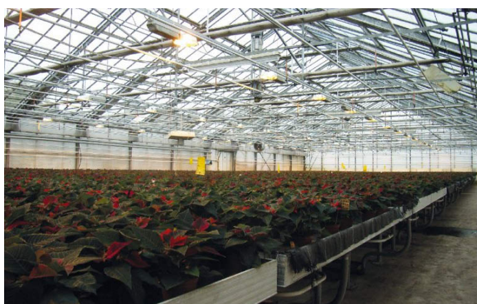
Auf 1500 Quadratmeter sind Assimilationslampen installiert
