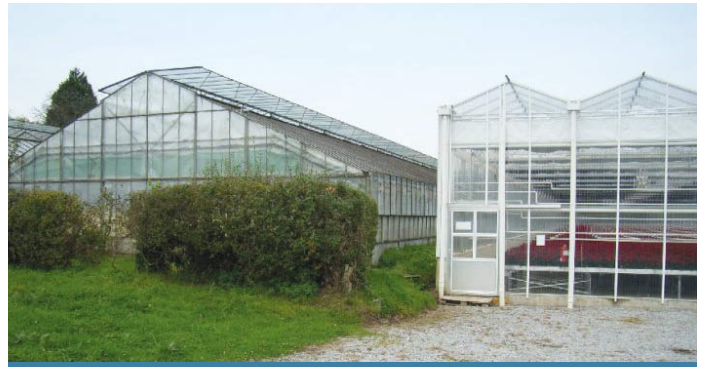
Der Neubau liegt etwas tiefer als die vorhandenen Häuser
